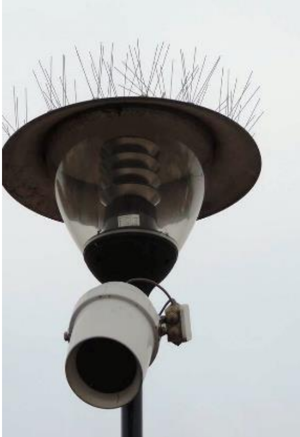
სურათი 6-45 ქეს-ის სხვადასხვა კონსტრუქციებზე დამაგრებული ფრინველსაწინააღმდეგო მოწყობილობები
