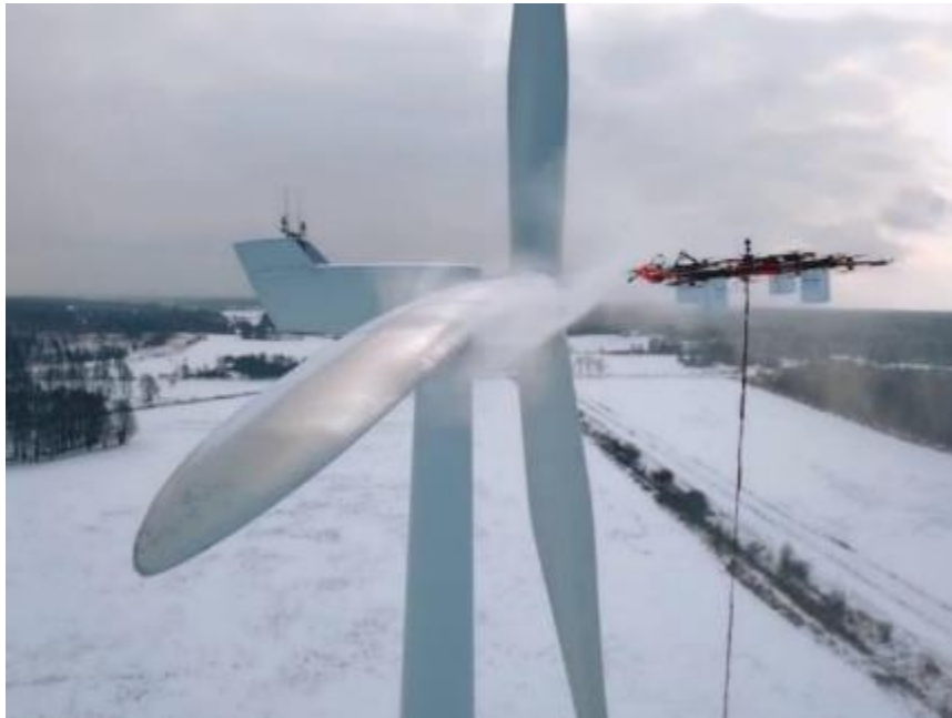
სურათი 6-56 დრონის გამოყენება ქარის ტურბინის გასაწმენდად
